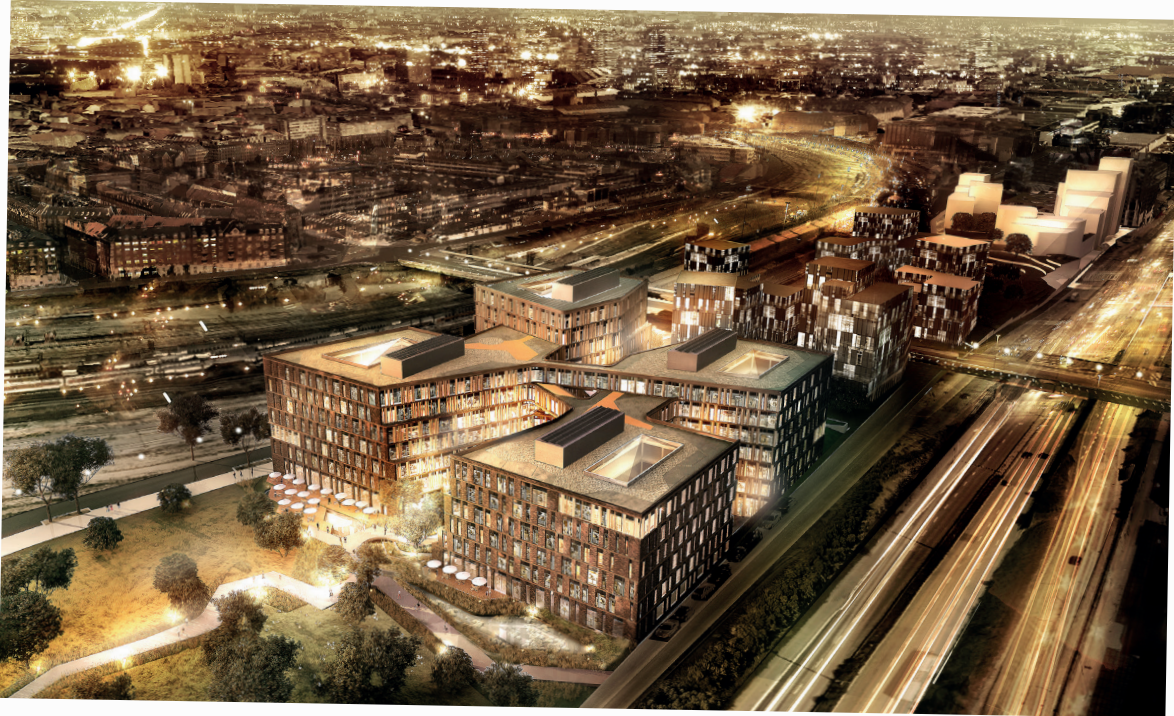
Projekt, Kalvebod Brygge.
